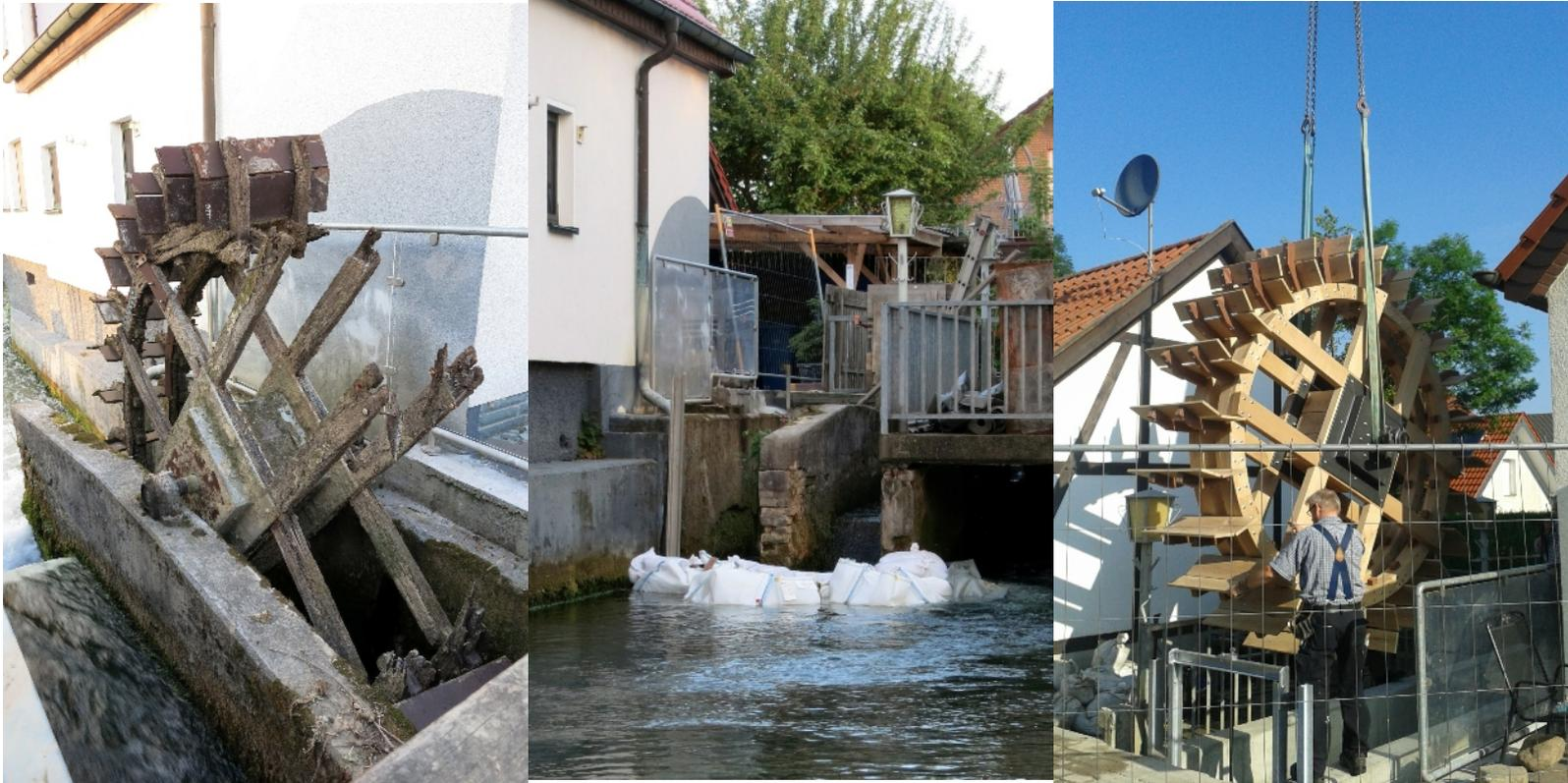
Zu den Bildern: Die Schäden an Mühlrad und Umflutrinne waren deutlich. Den Umbauarbeiten gingen viele umfangreiche Maßnahmen voraus, vor allem, um das Wasser von der Baustelle fern zu halten (Bild oben Mitte sowie Aufnahme unten). Die Heder nahm vorübergehend den Weg über die Überlaufschwelle durch den Quellteich. Oben rechts wird das neue Mühlrad bei bestem Sommerwetter eingebaut (Aufnahme von Petra Nolte). Der Einbau erfolgte am 30. Juni 2015.
