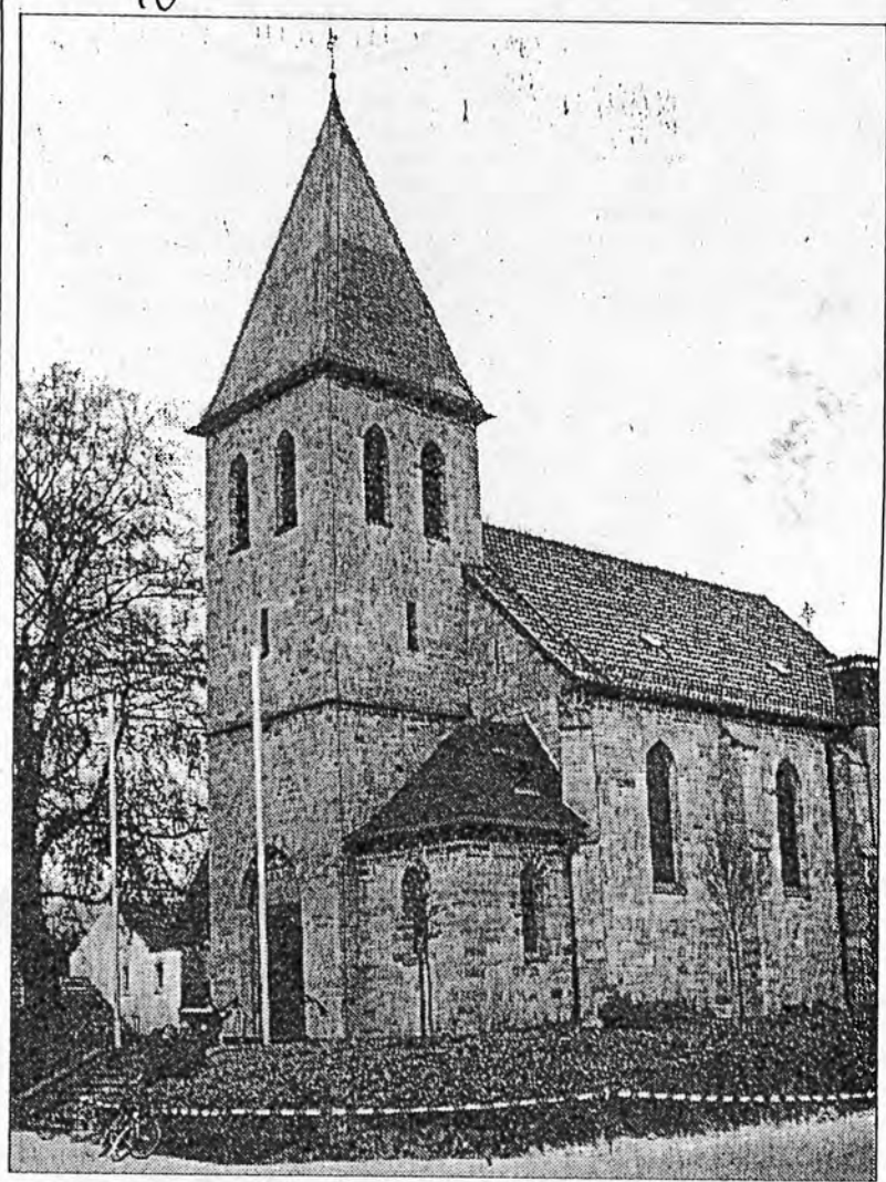
Die Pfarrkirche St. Petrus Upsprunge wurde vor 100 Jahren konsekriert. Zur Zeit wird die Kirchenmauer aus Bruchstein an drei Stellen erneuert. Bis auf die Abdeckplatten ist die Maßnahme bereits abgeschlossen. Erneuert wird in Kürze auch der Treppenaufgang.
